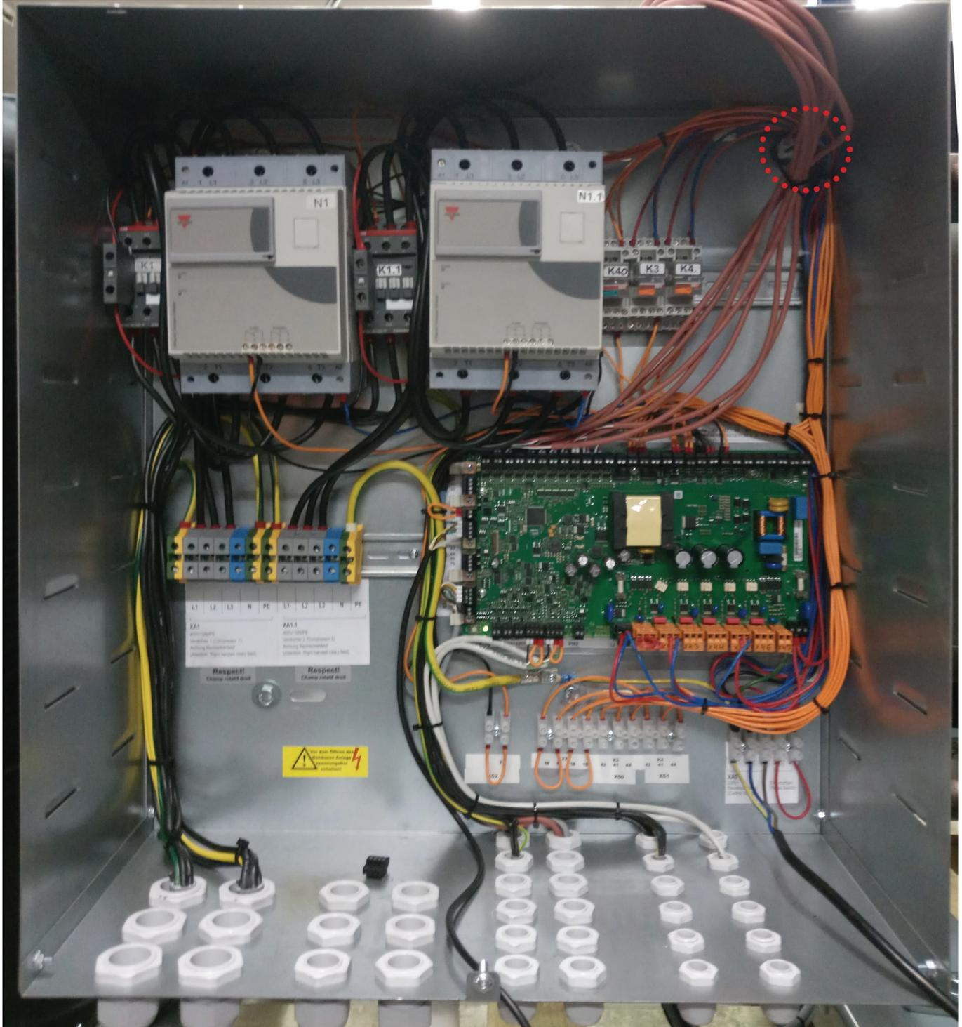
**Zusatz-Klemmleiste Tandem Großwärmepumpe HCS/HCW**
