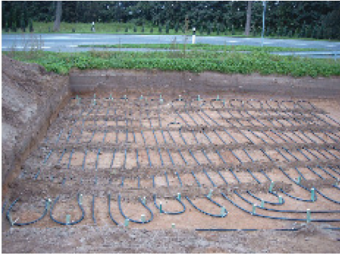
Verlegung des Erdkollektors
