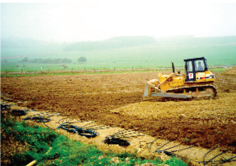
Wiederbefüllung des Erdkollektors mit Erdreich
